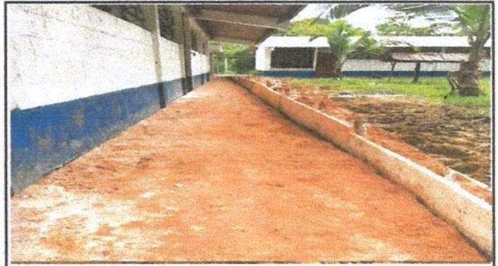
Reparación de plancha de concreto de patio
