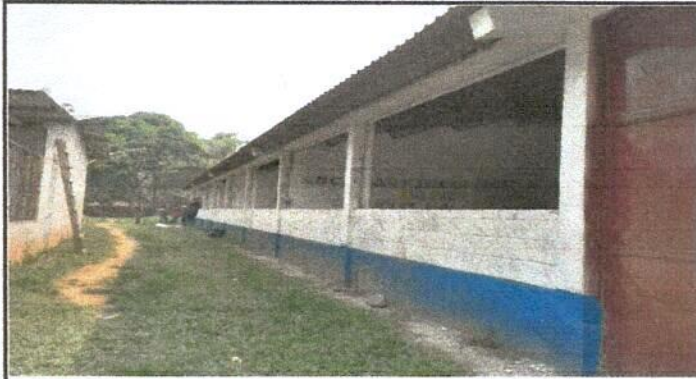
Sustitución de balcones de metal
