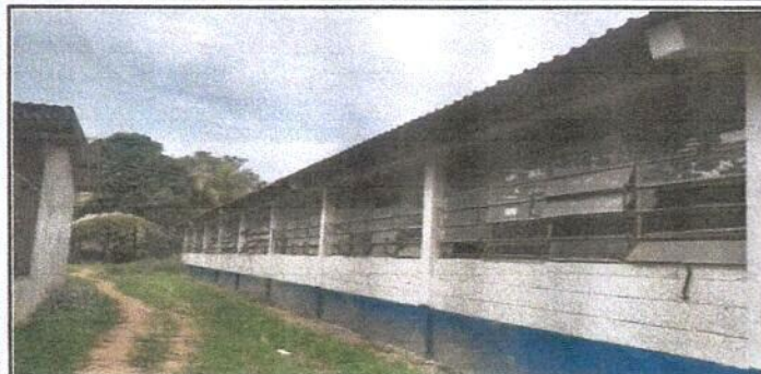
Sustitución de balcones de metal
