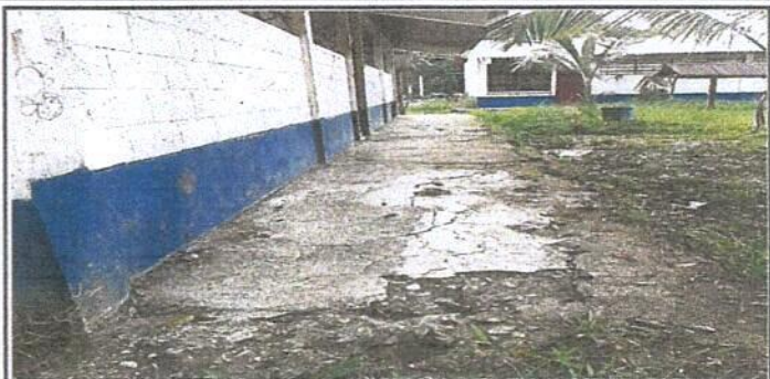
Reparación de plancha de concreto de patio
