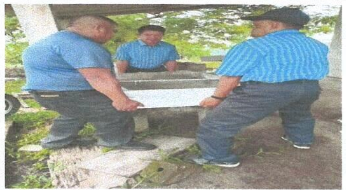
Foto 8: Sustitución de pila de concreto de dos lavaderos
