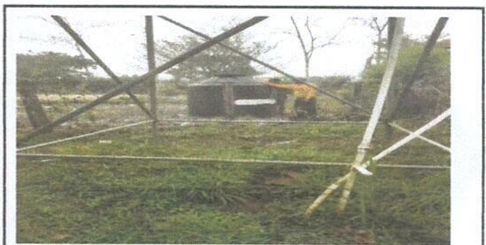
Foto 6: Sustitución de deposito de agua 1700 LT
