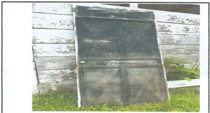
Foto 4: Sustitución de puerta
