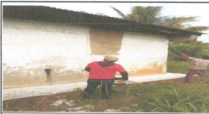
Foto 5: Pintura en muro exterior e interior
