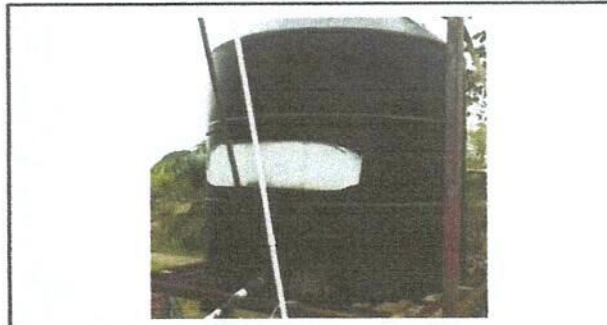
Foto 6: Sustitución de deposito de agua 1700 LT
