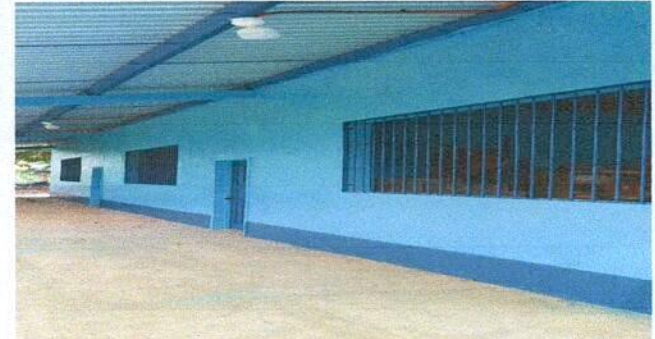
Foto 6: sustitucion de ventanas de madera por metal finalizado
