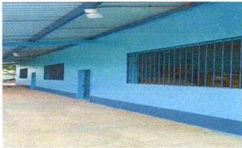
Foto 3: sustitucion de estructura de soporte de metal por metal
