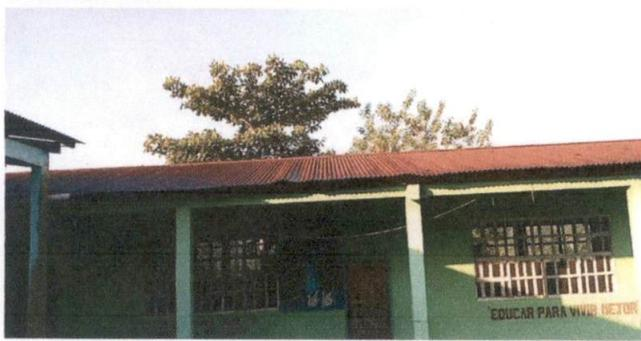
Foto1: sustitucion de lamina, por lamina troquelada aluzinc calibre 26 por mal estado.
