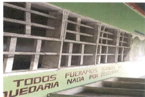
Foto 6: sustitucion de ventanas de madera por metal, madera en mal estado y en descomposicion.
