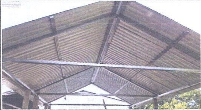
Foto 1: Sustitución de lámina, por lámina troquelada aluzinc calibre 26 de la cocina escolar
