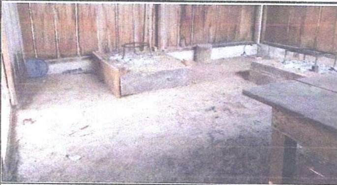
Foto 3: Sustitución de Piso de torta de concreto en la cocina
