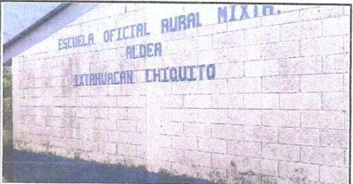
Foto 6: Pintura en muros exteriores e interiores
