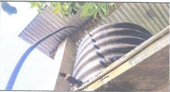
Foto 5: Sustitución de depósito de agua
