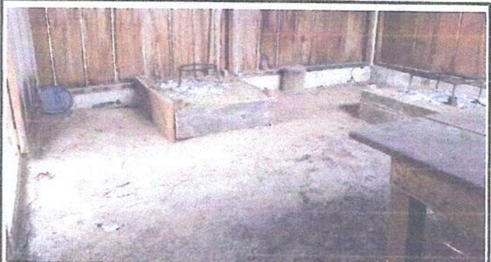
Foto 4: Sustitución de estufa rural completa, incluye chimenea y plancha de metal
