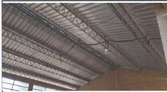
Foto 2: Mantenimiento de estructura de soporte de metal.
