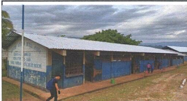
Foto1: Sustitución de Lámina por lámina troquelada del techo del edificio escolar.
