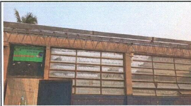
Foto 2: Mantenimiento de estructura de soporte de metal.
