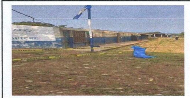
Foto 3: Sustitución de capote de lamina para lamina troquelada.
