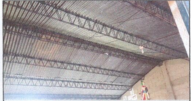
Foto 2: Mantenimiento de estructura de soporte de metal.
