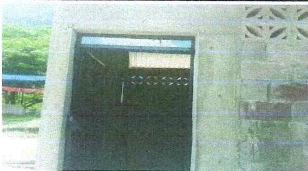
Foto 3: Sustitucion de puerta
