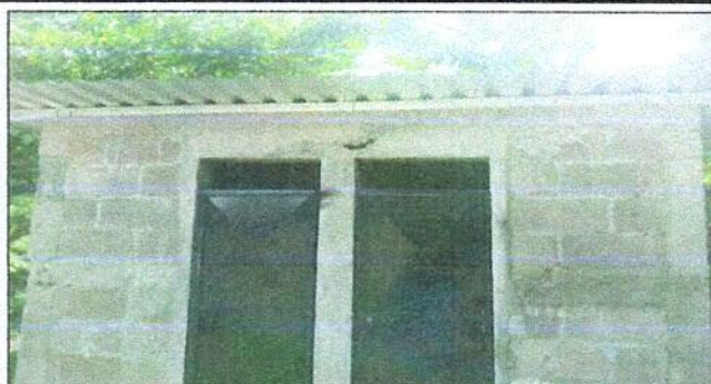
Foto 10. Sustitucion de estructura de soporte de madera, por metal
