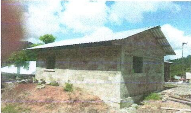
Foto1: Sustitución de lamina, por lamina troquelada aluzinc calibre 26
