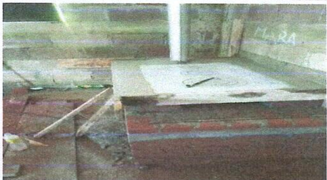
Foto 7: Sustitucion de estufa rural (completa) incluye chimenea y plancha de metal
