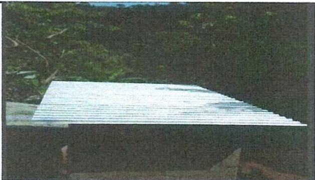
Foto 9: Sustitucion de lamina, por lamina troquelada aluzinc calibre 26
