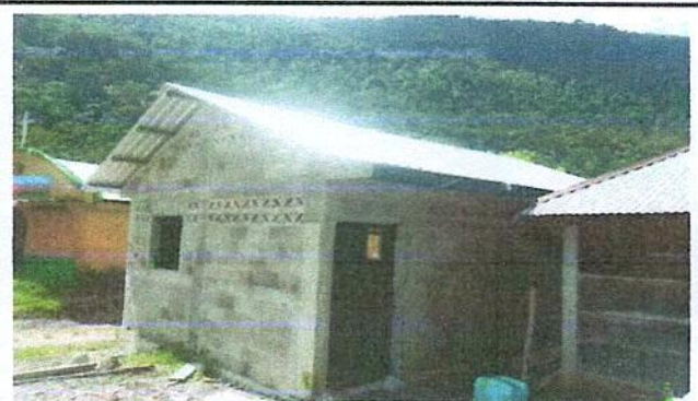
Foto 4: Sustitucion de estructura de metal de ventana
