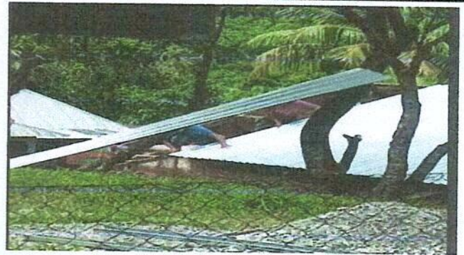
Foto 8: Sustitucion de lamina, por lamina troquelada aluzinc calibre 26
