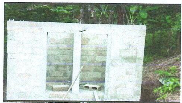
Foto 10: Sustitucion de estructura de soporte de madera, por metal
