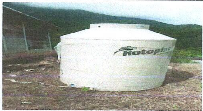
Foto 6: Sustitución de deposito de agua 1000 lt
