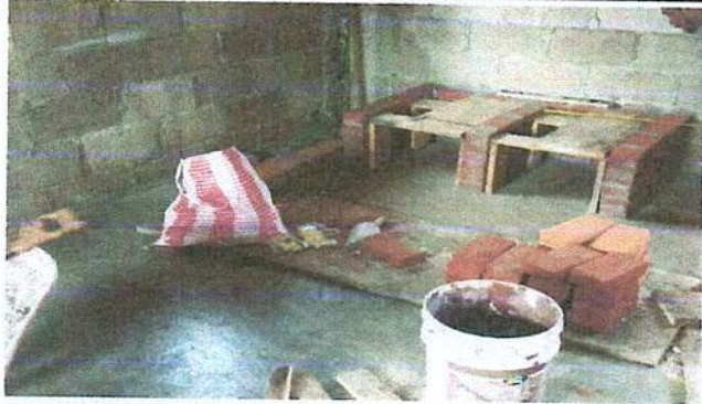
Foto 7: Sustitucion de estufa rural (completa) incluye chimenea y plancha de metal
