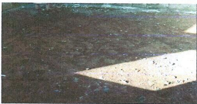
Foto 5: Sustitución de piso de torta de concreto
