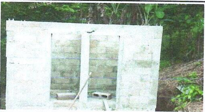
Foto 11. Sustitucion de puerta
