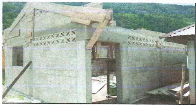
Foto 3: Sustitución de puerta
