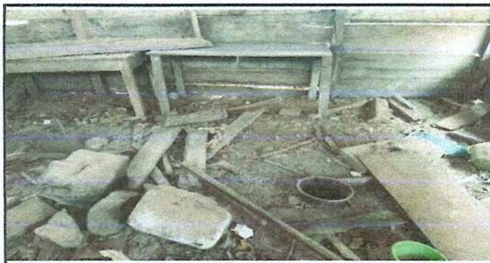
Foto 5: Sustitucion de piso de torta de concreto
