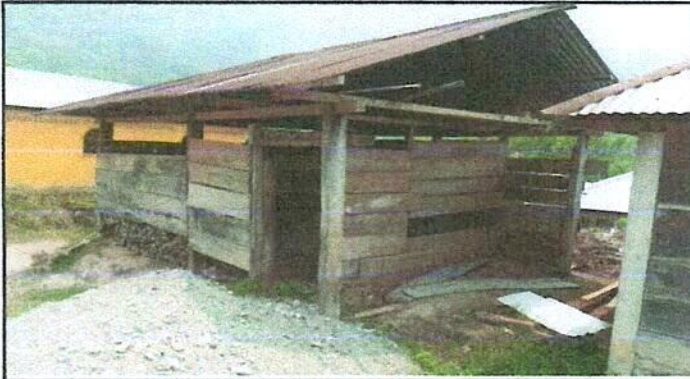
Foto1: Sustitucion de lamina, por lamina troquelada aluzinc calibre 26.
