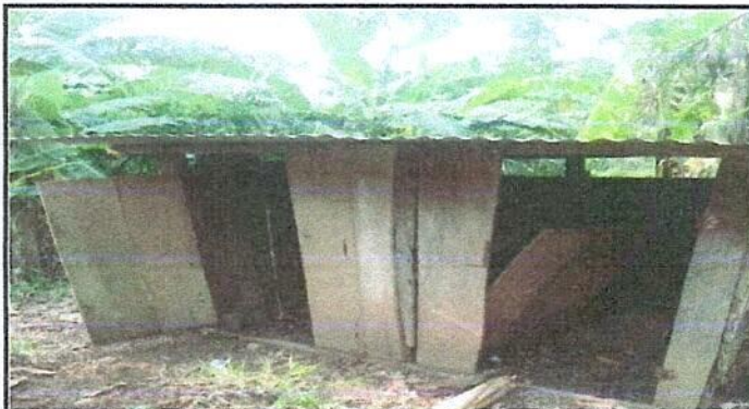
Foto 15. Sustitución de puerta
