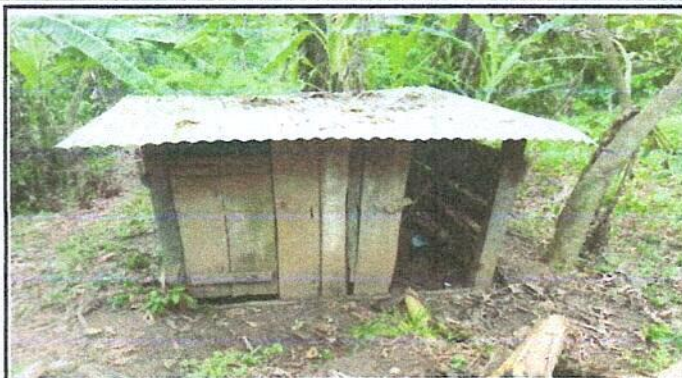
Foto 14. Sustitución de estructura de soporte de madera, por metal
