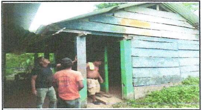
Foto 10: Sustitucion de puerta
