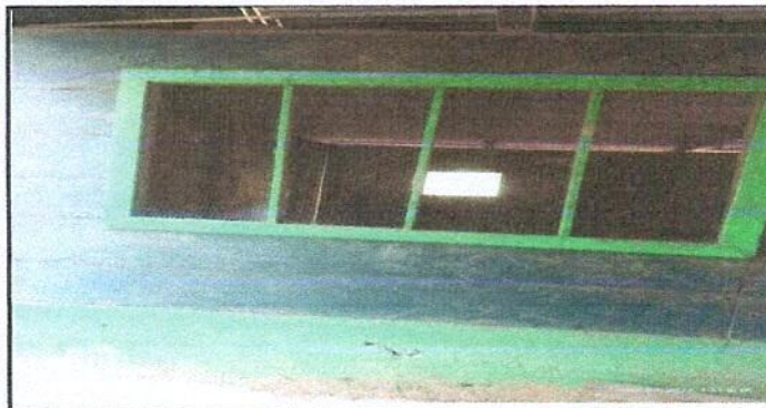
Foto 11. Sustitucion de estructura de metal de ventana
