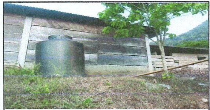
Foto 6: Sustitucion de deposito de agua 1000 lt
