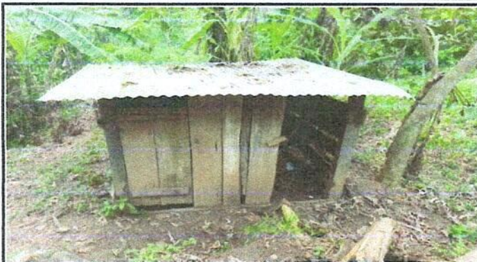
Foto 13: Sustitución de lamina, por lamina troquelada aluzinc calibre 26
