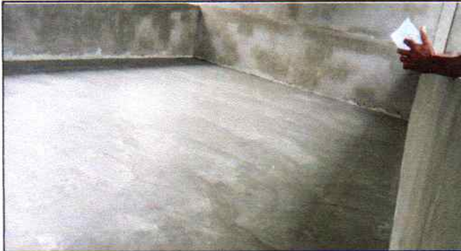
Foto1: Culminacion de piso de torta de concreto.
