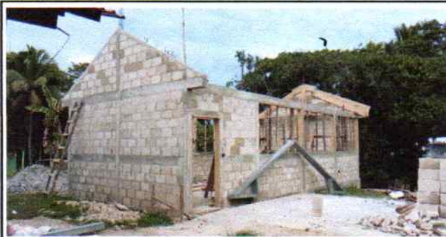
Foto 5: Nivelando la altura del techo.
