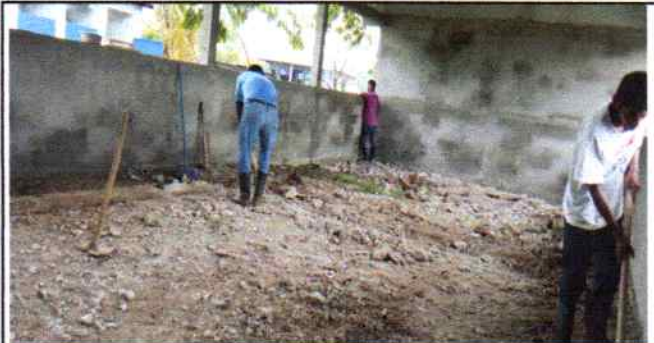
Foto 6: Planeación de torta de concreto.
