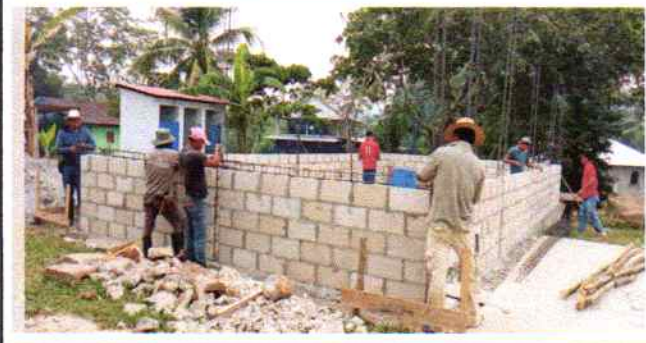
Foto 3: Avance de 5 hiladas de block.
