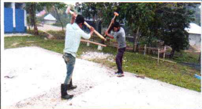
Foto 2: Inicio de trabajo.
