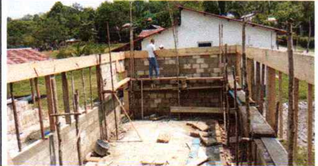
Foto 4: Cajoneando para la solera.
