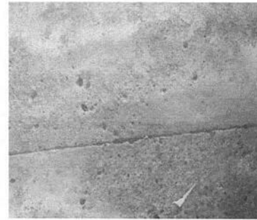
Foto 4: Sustitución de torta de cemento en mal estado.
