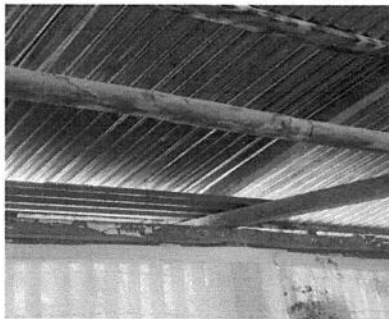
Foto 5: Sustitución de vigas de madera por estructura metálica en mal estado.
