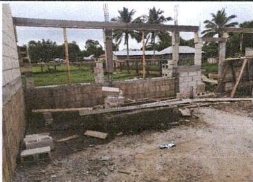
Foto 5: Dentro de la Cocina durante.
