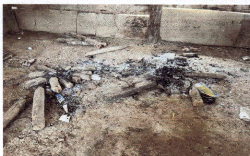
Foto 8: ÁREA DE COCINA, SIN TORTA DE CONCRETO, DÁNDOLE USO AL ESPACIO SOBRE TIERRA.
