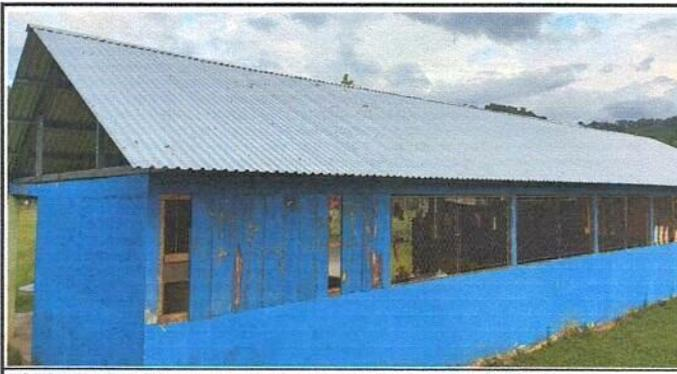
FOTO 5: Se sustituyó capotes de lámina, por capote dentada.
