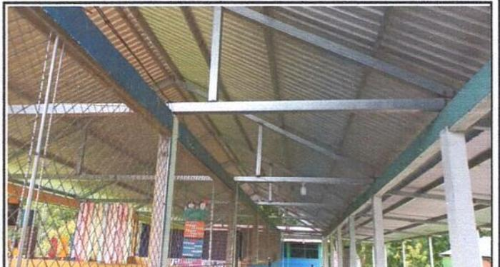
FOTO 4: Se sustituyó la estructura de madera por estructura metálica.
