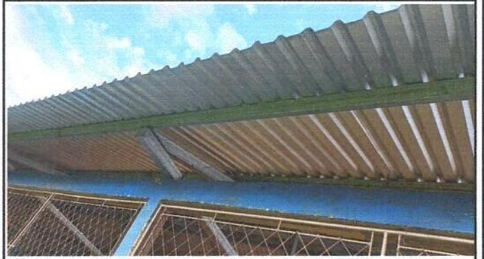
FOTO 2: se sustituyó la estructura de madera por estructura metálica.
