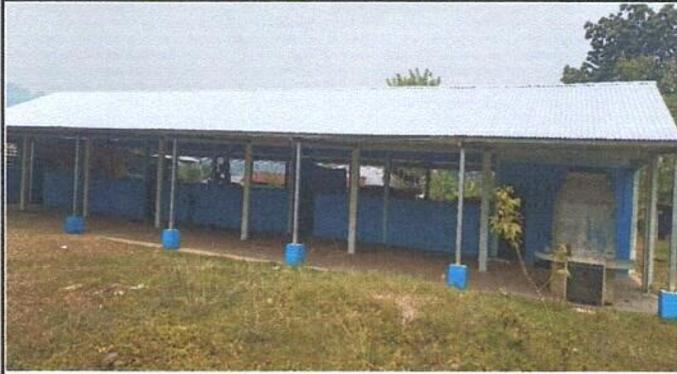
FOTO 1: Se sustituyó por completo por lámina troquelada, el edificio escolar.
