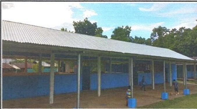
FOTO 3: Sustitucion de lamina, por lámina troquelada.
