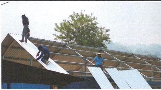
FOTO 1: Sustitucion de laminas por laminas troqueladas.
