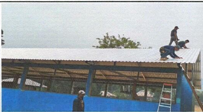
FOTO 3: Sustitucion de lámina por lámina troquelada.
