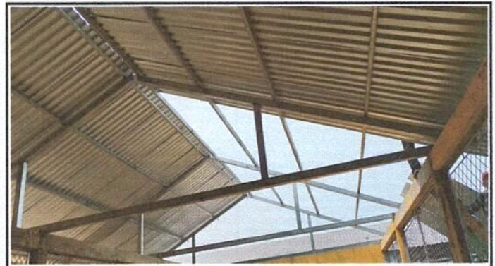
FOTO 4: Sustitucion de estructuras de madera por estructura metálica.
