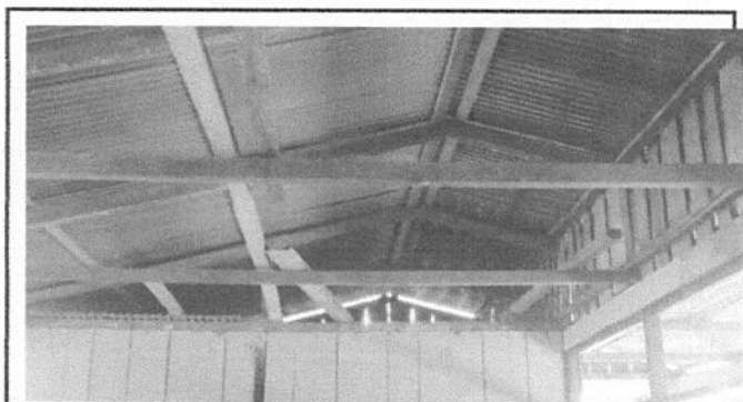
foto 4. sustitucion de estructuras de madera por estructura metal.
