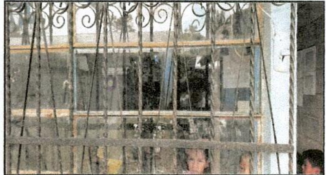
Foto 2: Sustitución de vidrios
