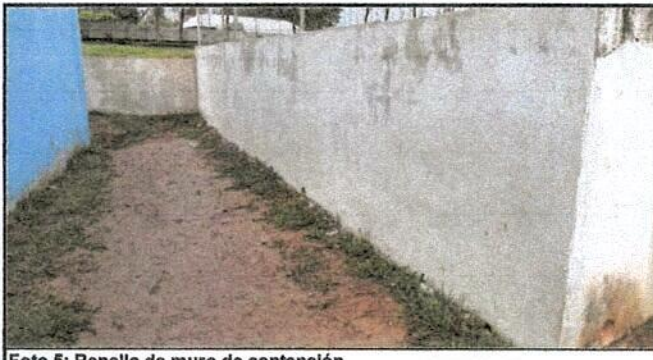
Foto 5: Repello de muro de contención
