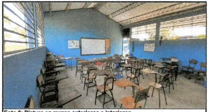
Foto 6: Pintura en muros exteriores e interiores
