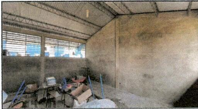
Foto 7: Repello en muro de aulas
