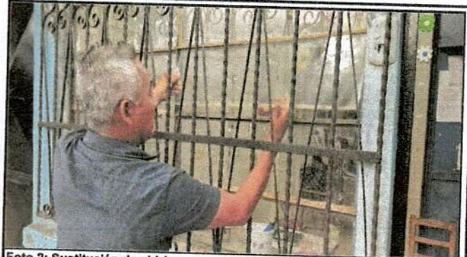
Foto 2: Sustitución de vidrios
