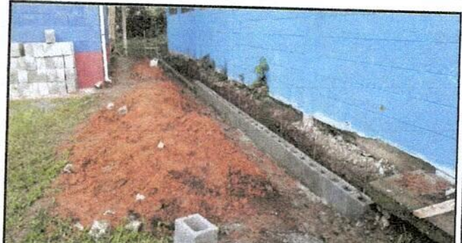
Foto 4: Reparación de cuneta y reparación de banqueta de concreto
