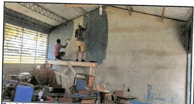
Foto 6: Pintura en muros exteriores e interiores
