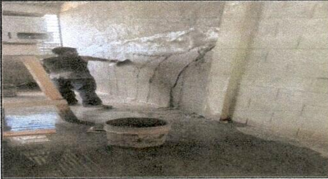
Foto 7: Repello en muro de aulas
