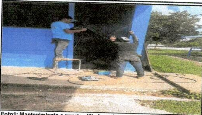
Foto 1: Mantenimiento a puertas (lijado, aplicación de pintura) y sustitución de puertas
