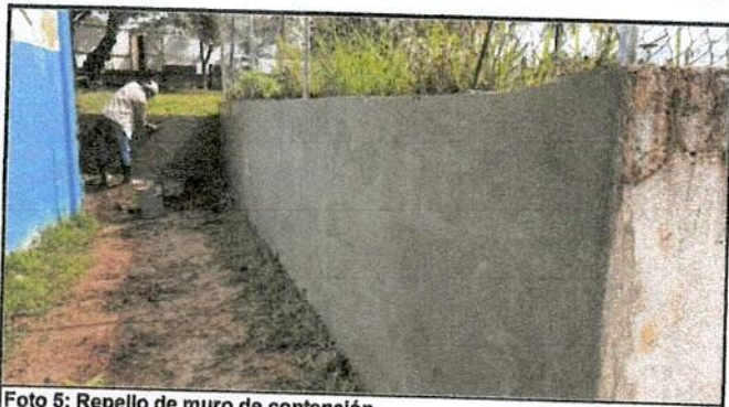
Foto 5: Repello de muro de contención
