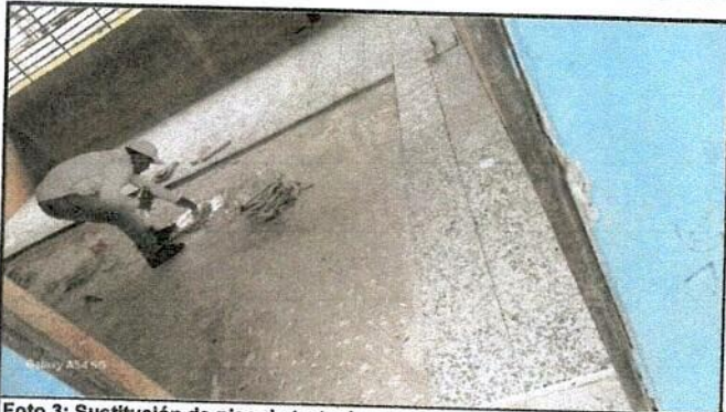
Foto 3: Sustitución de piso de torta de concreto por piso de granito
