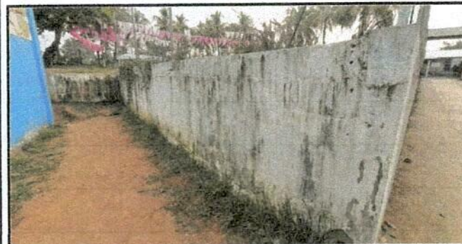
Foto 5: Repello de muro de contención
