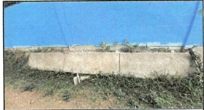
Foto 4: Reparación de cuneta y reparación de banqueta de concreto
