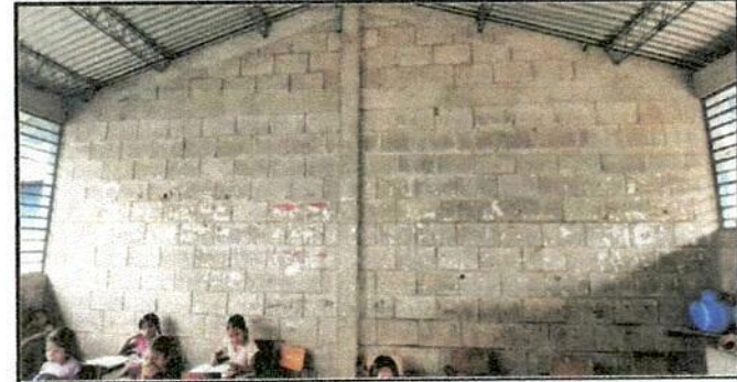
Foto 6: Pintura en muros exteriores e interiores
