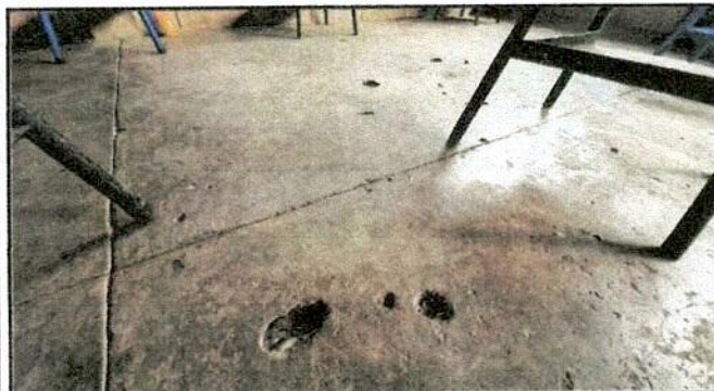
Foto 3: Sustitución de piso de torta de concreto por piso de granito
