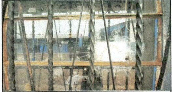
Foto 2: Sustitución de vidrios
