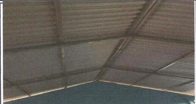
Foto 2: Sustitución de estructura de madera por metal
