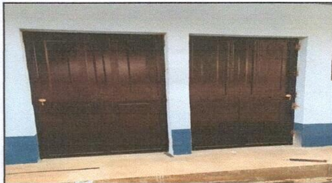
Foto 3: Sustitución de puerta de madera por metal
