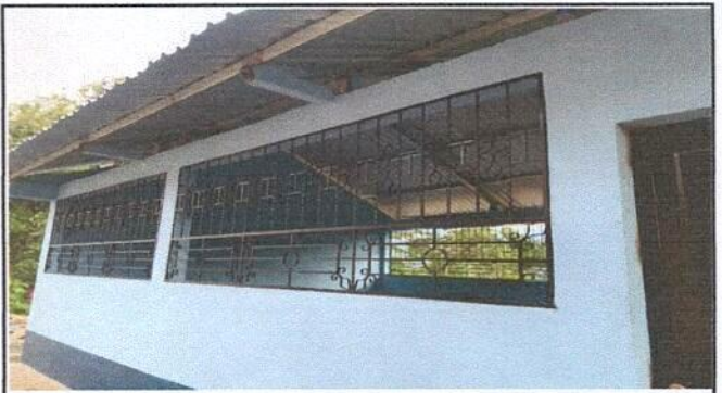
Foto 4: Sustitución de ventanas de malla por balcones de metal
