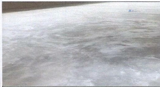
Foto 5: Sustitución de piso de torta de cemento.
