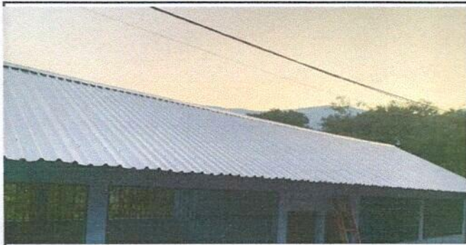
Foto 1: Sustitución de lámina por lámina troquelada calibre 26
