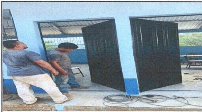
Foto 3: Sustitución de puerta de madera por metal
