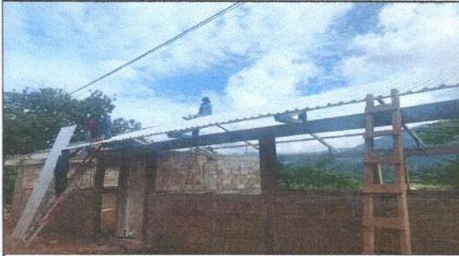
Foto 1: Sustitución de lámina por lámina troquelada calibre 26
