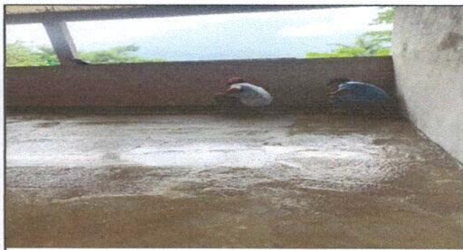
Foto 5: Sustitución de piso de torta de cemento.
