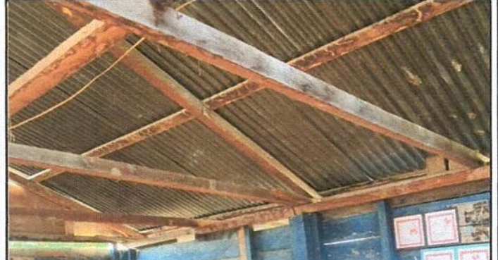
Foto 2: Sustitución de estructura de madera por metal
