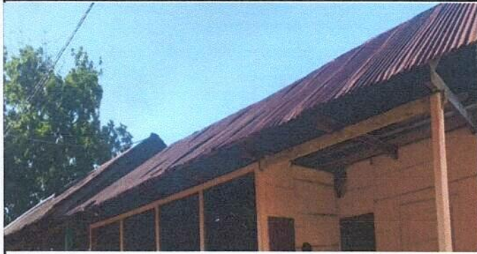
Foto 1: Sustitución de lámina por lámina troquelada calibre 26
