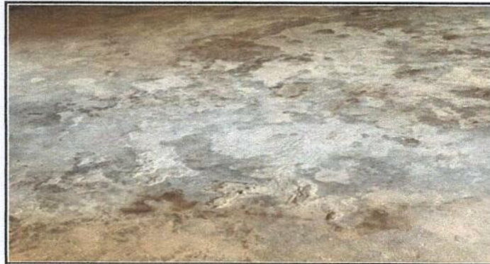
Foto 5: Sustitución de piso de torta de cemento.
