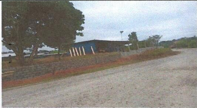
Foto1: Vista general del Establecimiento Educativo.
