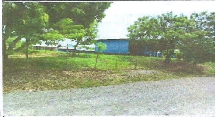
Foto 1: Vista general del Establecimiento Educativo.
