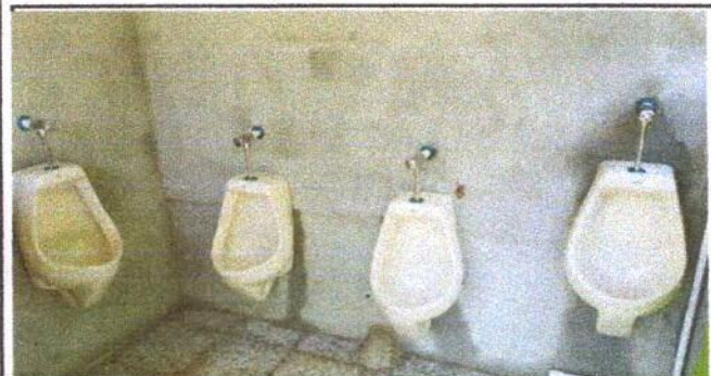
Foto 4: Sustitución de mingitorios
