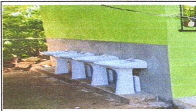
FOTO 2: Sustitución de lavamanos
