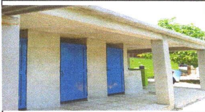
FOTO 1: Sustitución de puertas
