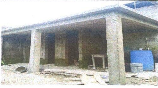
FOTO 1: Sustitución de puertas
