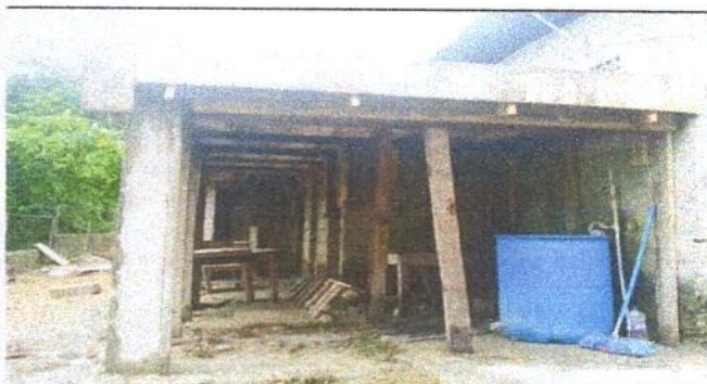
Foto 4: Sustitución de mingitorios
