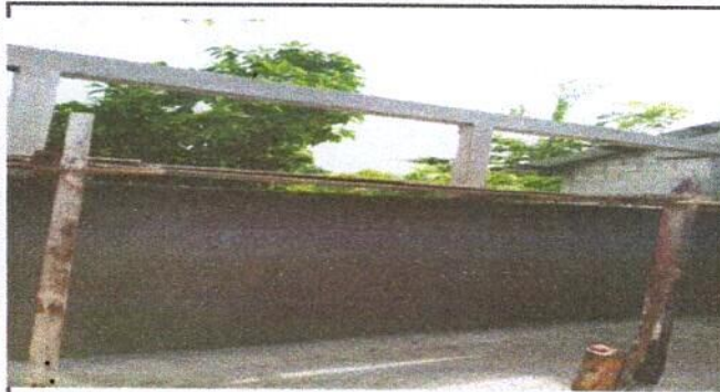
FOTO 2: Sustitución de lámina por lámina troquelada
