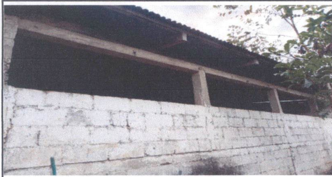
FOTO 2: Sustitución de lámina por lámina troquelada
