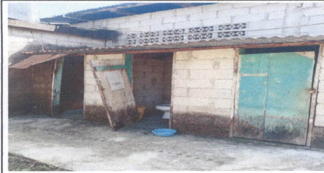
FOTO 1: Sustitución de puertas
