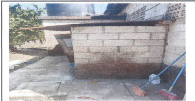
FOTO 4: Sustitución de mingitorios
