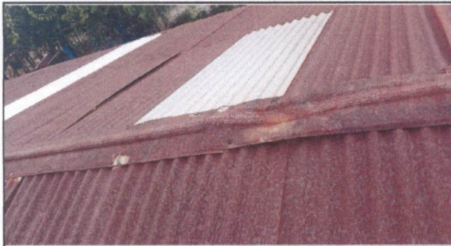
Foto 3: Sustitucion de capote de lamina para lamina troquelada.
