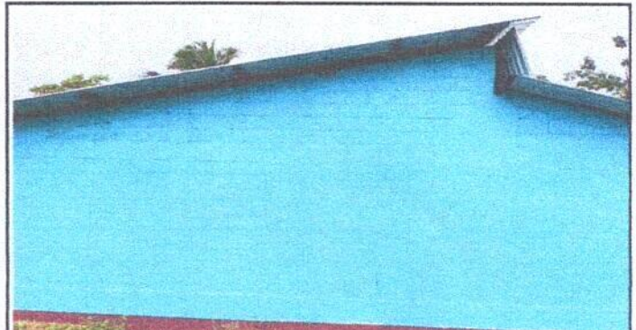
Foto 4: Sustitución de estructura de soporte de metal por metal
