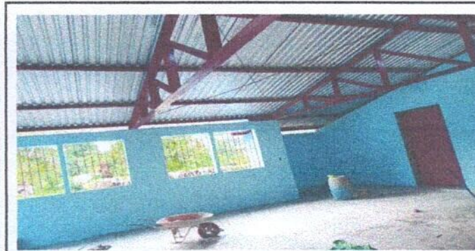
Foto 3: Sustitución de piso de torta de concreto
