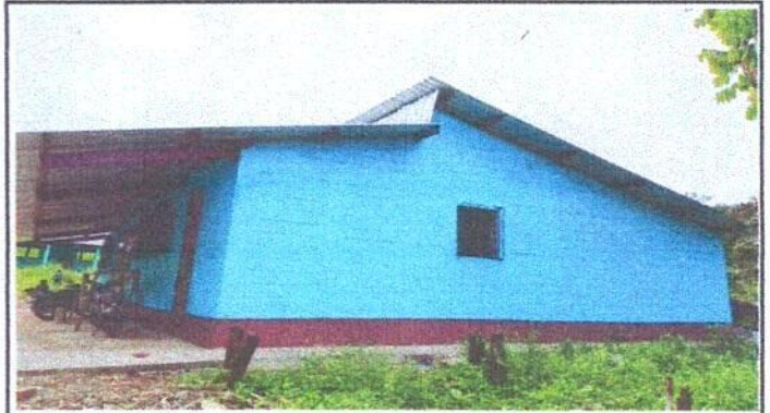
Foto 2: Sustitución de capotes
