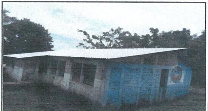
Foto 4: Sustrucción de estructura de soporte de metal por metal
