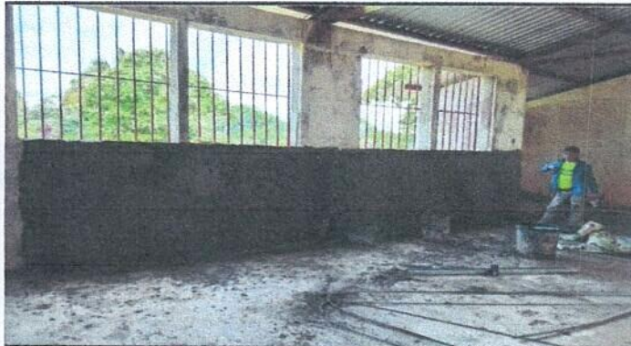
Foto 3: Sustrucción de piso de torta de concreto
