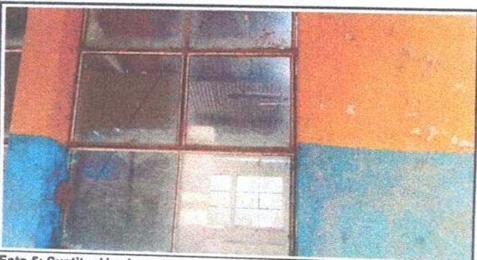
Foto 5: Sustrucción de ventanas de vidrio por balcones de metal
