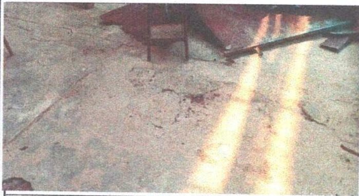
Foto 3: Sustrucción de piso de torta de concreto
