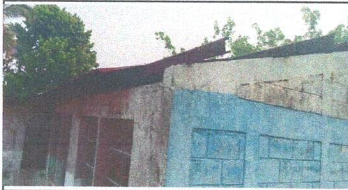
Foto 1: Sustrucción de cubierta de lámina del Centro Educativos
