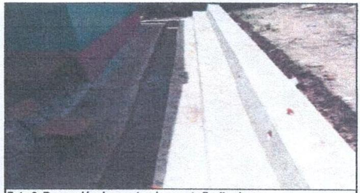
Foto 6: Reparación de cuneta y banqueta finalizado
