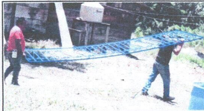
Foto 3: Colocación de balcones de metal
