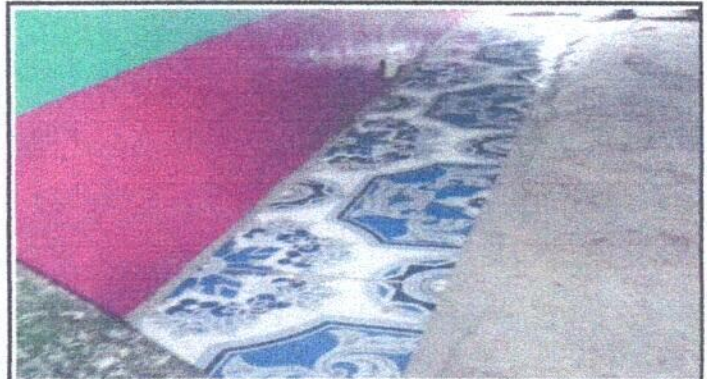
Foto 4: Sustitución de piso por cerámica
