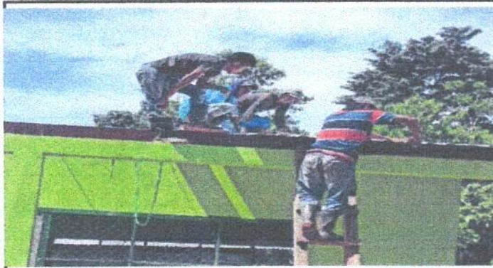
Foto1: Sustitución cubierta de lamina
