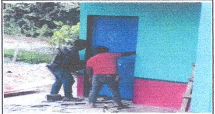
Foto 2: Sustitución de puerta de metal
