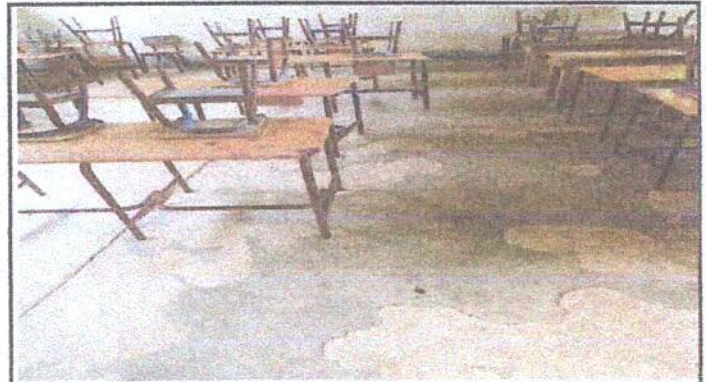
Foto 3: Sustitucion de piso por piso de granito
