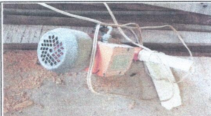
Foto 2: Sustitución de bomba de agua
