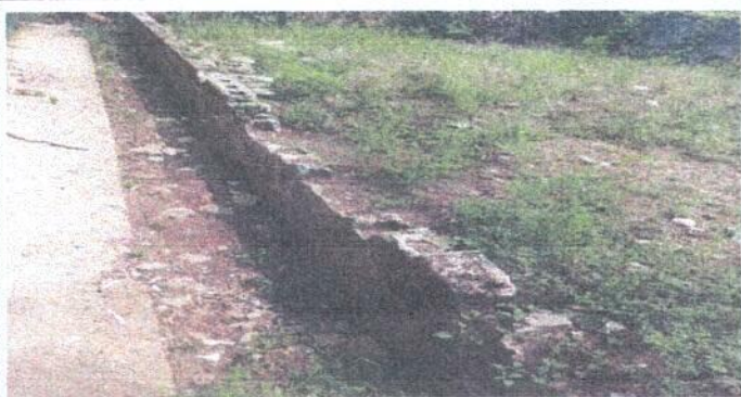
Foto 3: Reparación de muro de contención
