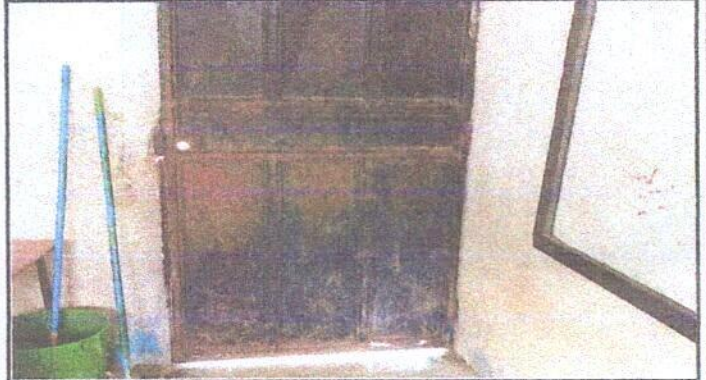
Foto 2: Sustitucion de puerta de metal por metal
