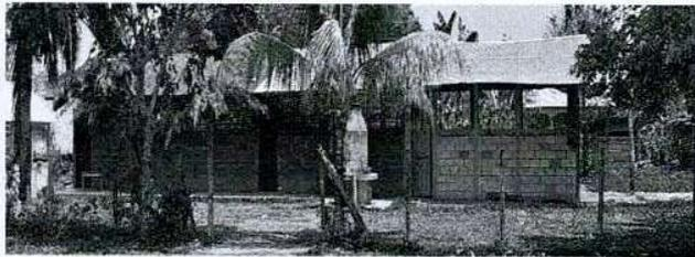
Foto 3: circulación frontal de malla y poste de madera en mal estado.
