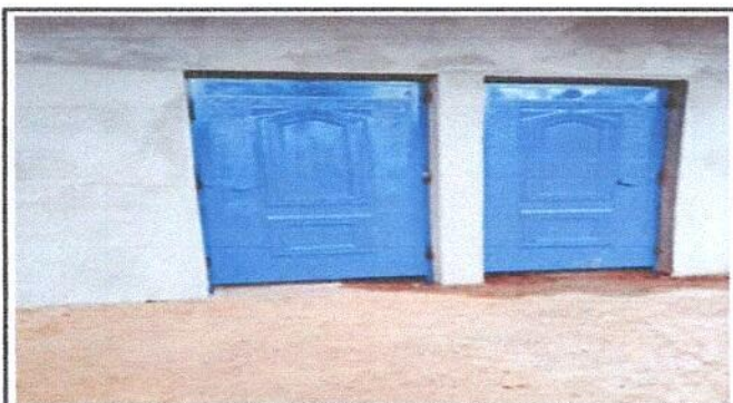
Foto 3: INSTALACIÓN DE PUERTAS EN CADA AULA.
