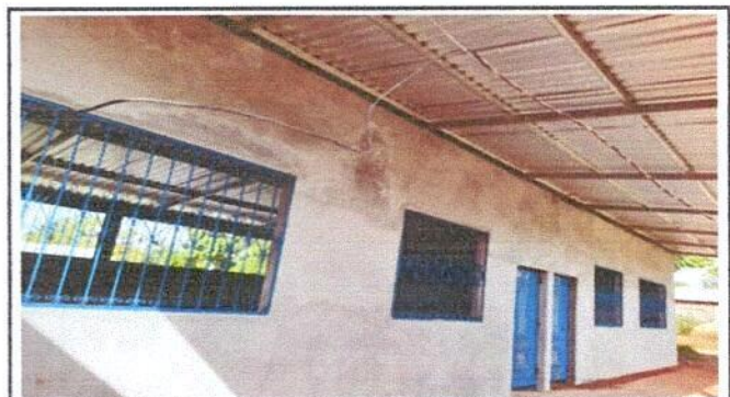
Foto 4: INSTALACIÓN DE TECHO DE CORREDOR.
