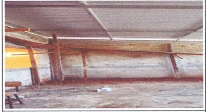
Foto 2: INSTALACIÓN DE LÁMINAS O TECHO.
