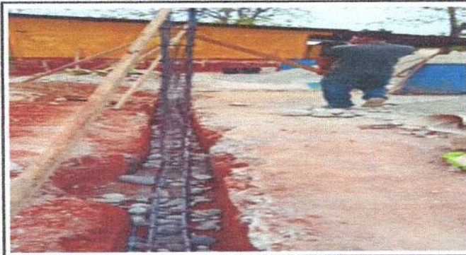
Foto 1: FUNDICIÓN Y CIMENTACIÓN DEL EDIFICIO.
