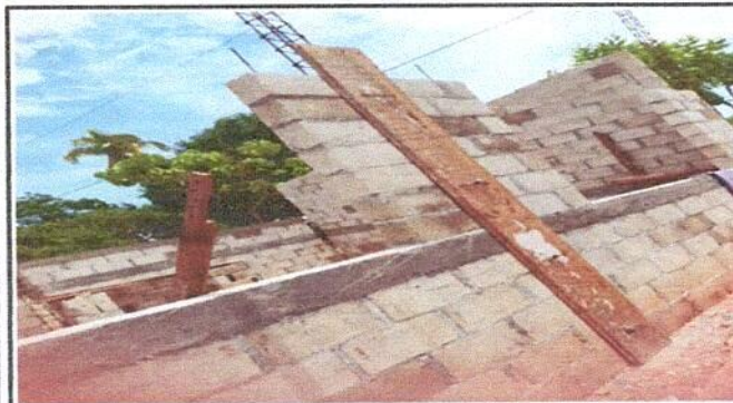
Foto 3: FUNDICIÓN DE COLUMNAS DE SOPORTE.
