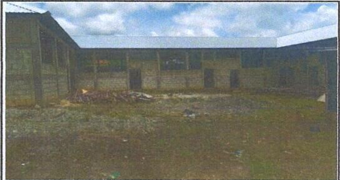
Foto 4: Vista general de la parte interna del centro educativo, tomada del ángulo Norte. (Techado)
