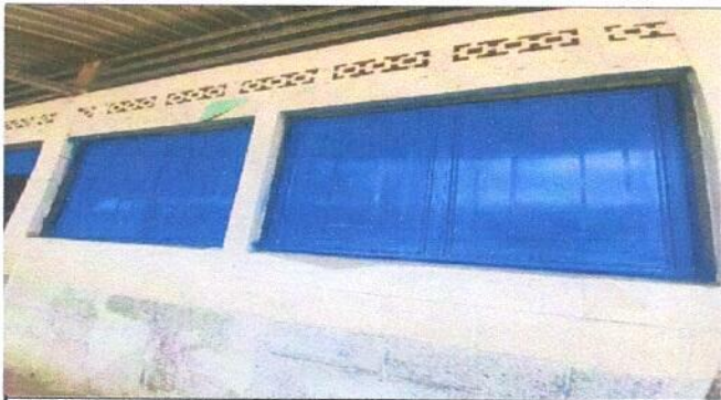
Foto 3: Sustitución de ventanas de madera por metal.
