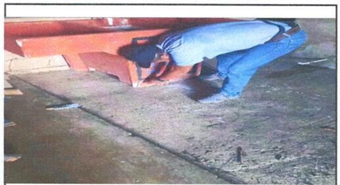
Foto 4: Instalación de pila de concreto.
