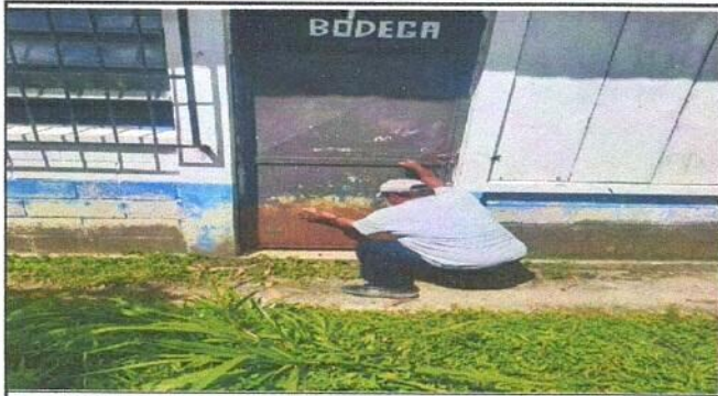
Foto1: Mantenimiento a estructura de puerta (lijado, cepillado y pintura).
