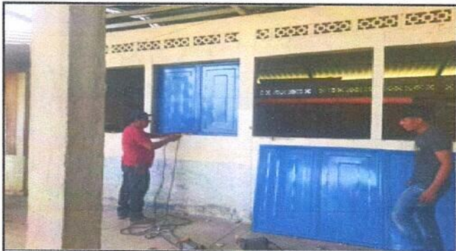
Foto 3: Sustitución de ventanas de madera por metal.
