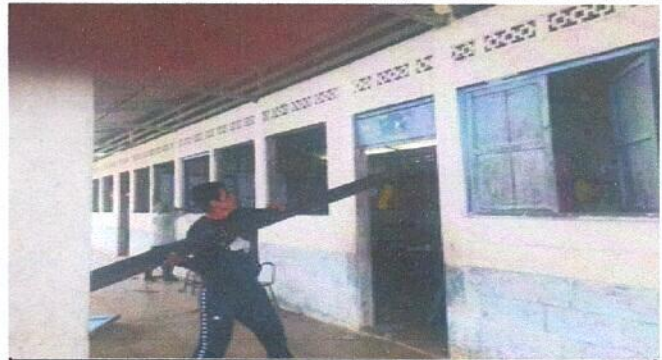
Foto 2: Sustitución de puerta de madera por metal del centro educativo.
