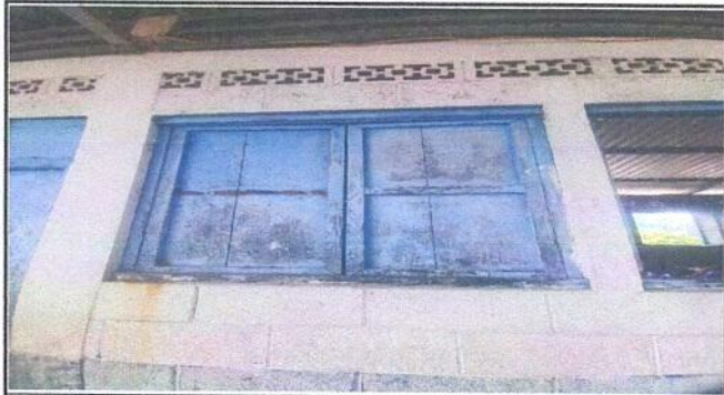
Foto 3: Sustitución de ventanas de madera por metal.
