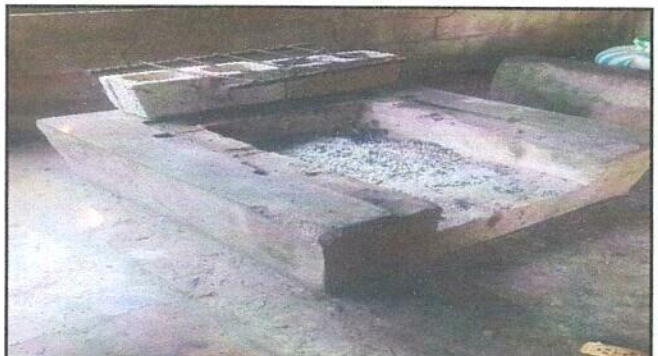
Foto 4: Instalación de chimenea.
