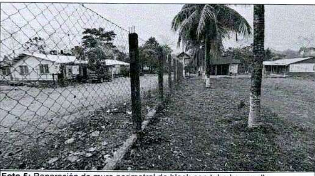
Foto 5: Reparación de muro perimetral de block con tubo hg y malla galvanizada, soleras intermedias y columnas.
