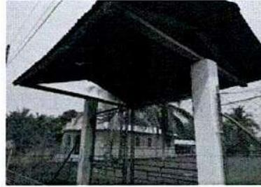
Foto 2: MÓDULO 1. REMOZAMIENTO ESTRUCTURA DE TECHO DE LÁMINA EN MAL ESTADO, DEL PORTON.
