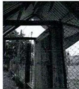
Foto 4: MODULO 1. REMOZAMIENTO ESTRUCTURA DEL TECHO DE LAMINA DE LA PUERTA DE EMERGENCIA DEL ESTABLECIMIENTO DE MADERA A METAL.
