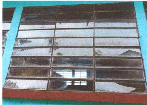
Foto 4: Sustrucción de vidrios en mal estado en todas las ventanas
