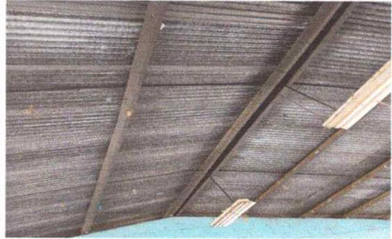
Foto2: Sustrucción de lámina por lámina troquelada
